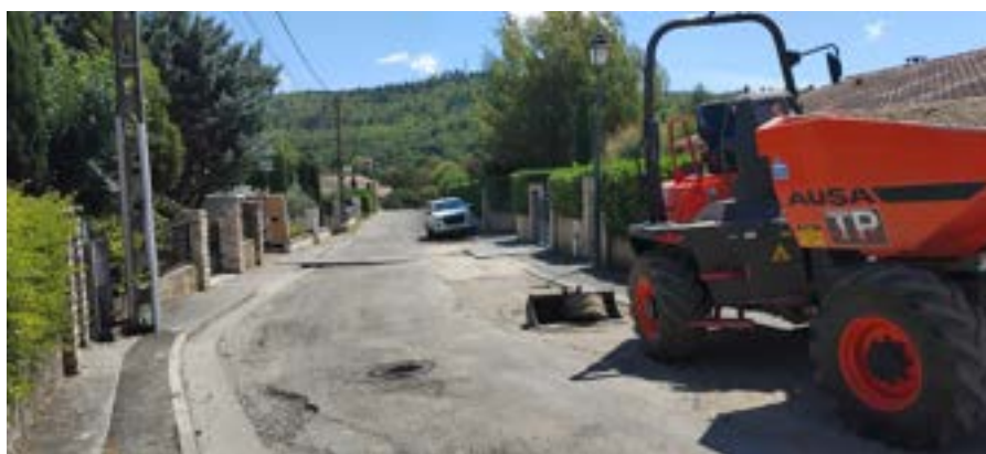
Figure n°12 : photo de la zone de travaux avenue de la Falaise à Céreste en Luberon
