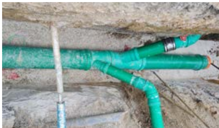
Figure n°11 : photo des travaux à Gargas
