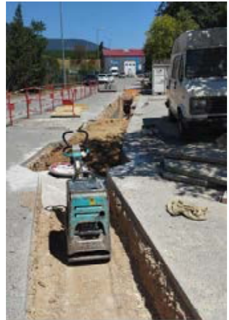
Figure n° 13 : photo de la zone de travaux zone d'activités de Triquefauts à St Saturnin Les Apt
