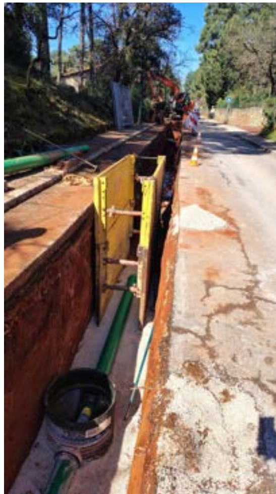
Figure n°10 : photo des travaux de la création du réseau de transfert à Roussillon
