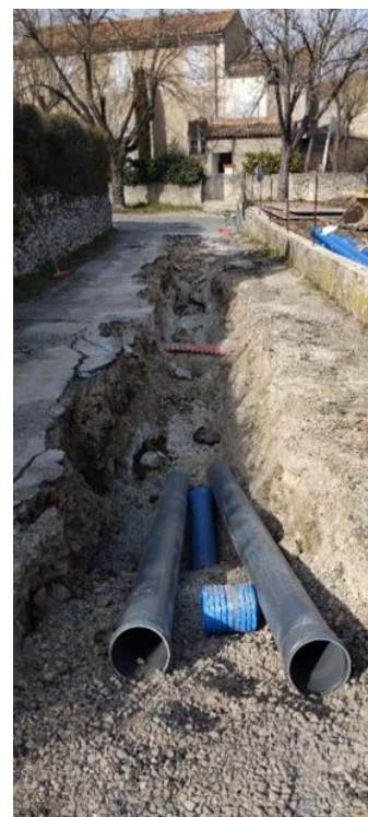
Figure n°19 : photo des travaux de renouvellement de réseau à Céreste
