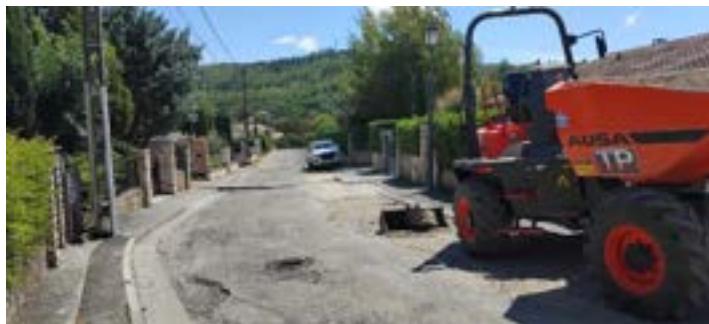
Figure n°18 : photo de la zone de travaux avenue de la Falaise à Céreste en Luberon
