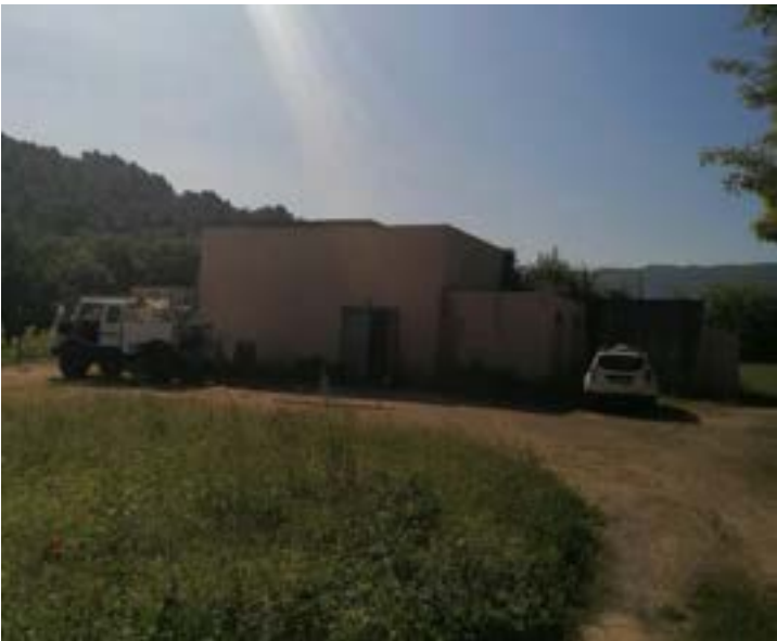
Figure n°4 : photo du site des forages du Fangas
