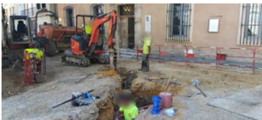
Figure n°20 : photo des travaux de renouvellement du réseau place Jean Jaurès à Apt
