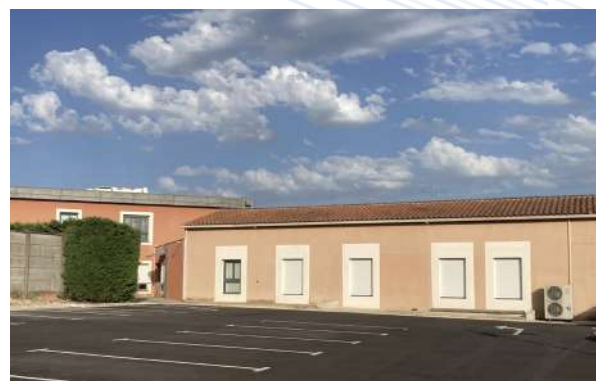
Extension du siège de la Communauté de Communes et création du parking du personnel
