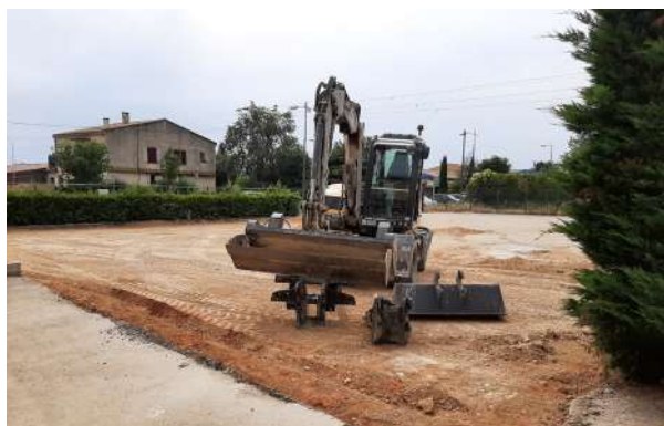
Création du parking du personnel de la Communauté de Communes
