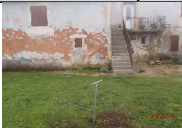
Vue d'ensemble du Sondage
